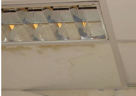
Contamination sur dalle de plafond acoustique (bureau)
